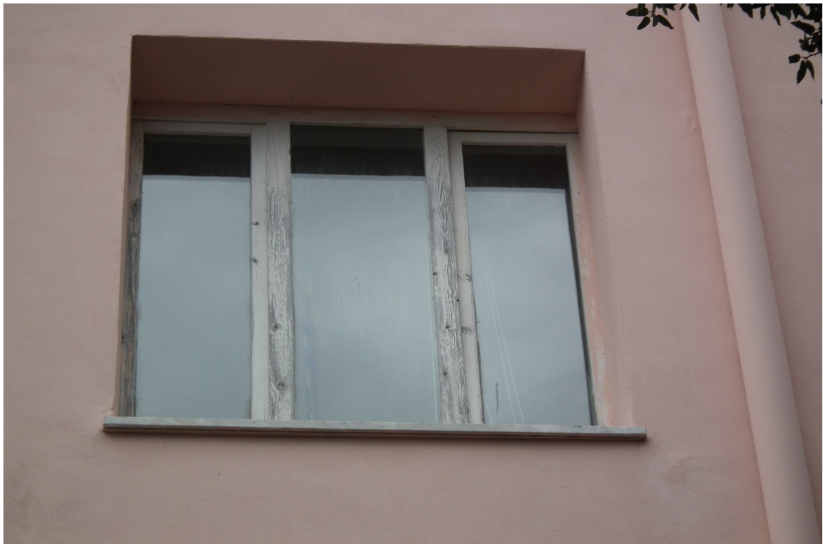
Foto 27 – Particolare di un infisso esterno al primo piano da sostituire
