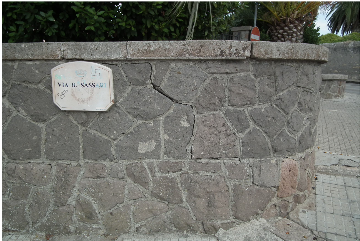
Foto 5 – Muratura di recinzione su via Brigata Sassari: lesioni sulla muratura
