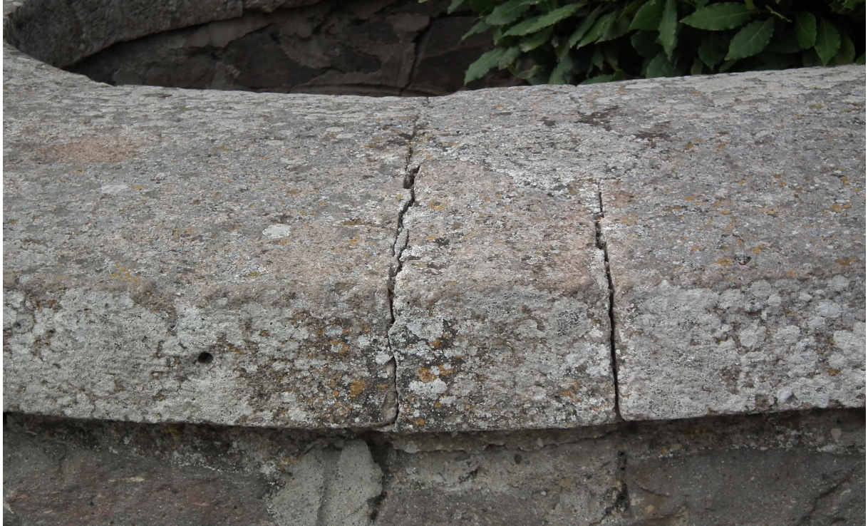
Foto 4 – Muratura perimetrale su via Dante: particolare delle lesioni sulla copertina
