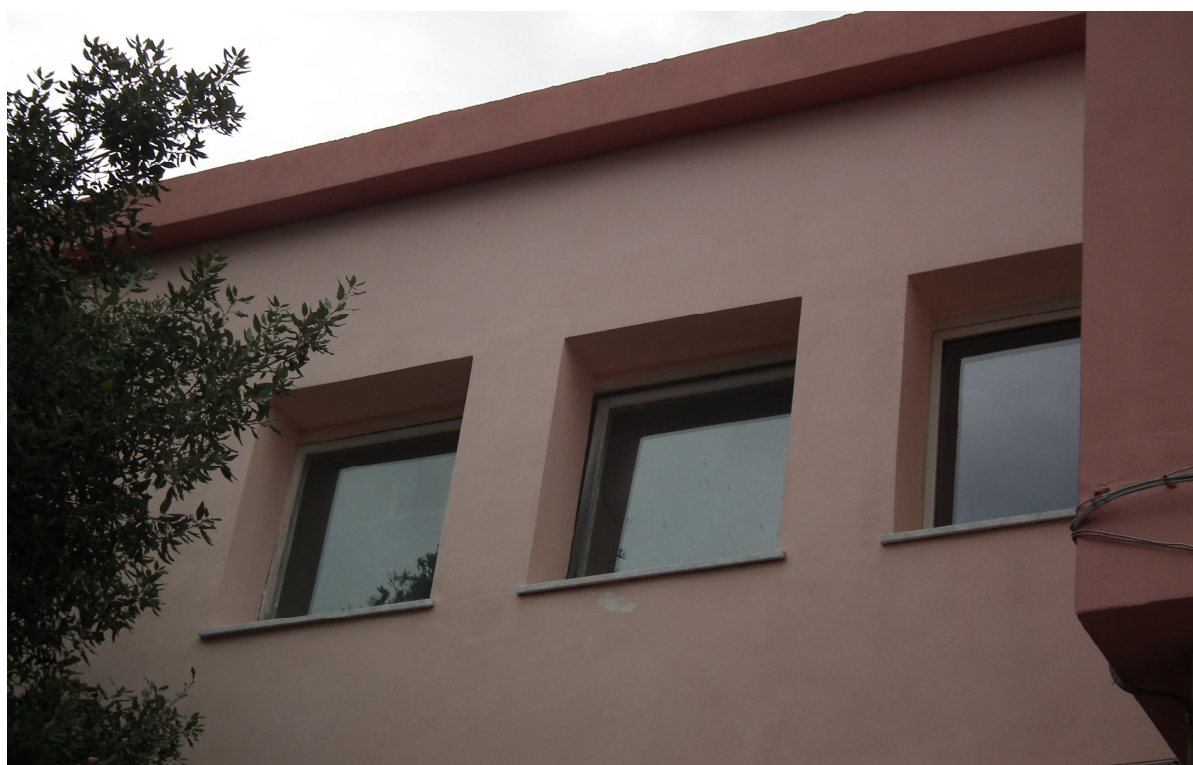
Foto 24 - Particolare delle finestre da sostituire dei bagni
