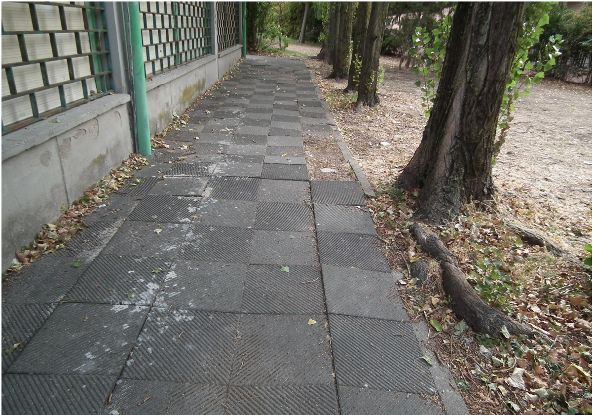
Foto 11 – Particolare della pavimentazione dissesata a causa delle radici degli alberi da potare
