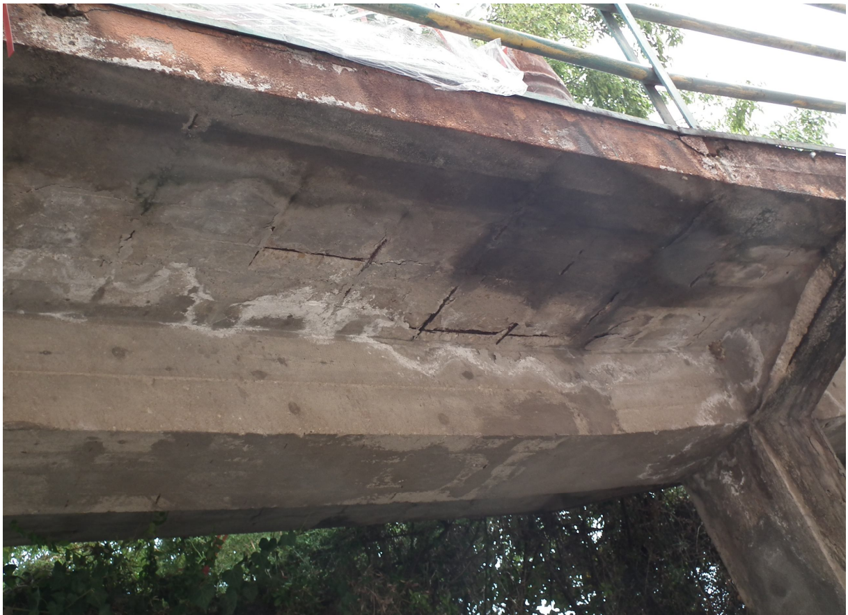
Foto 15 – Trave e soletta in c.a della passerella pedonale con esposizione dei ferri di armatura.
