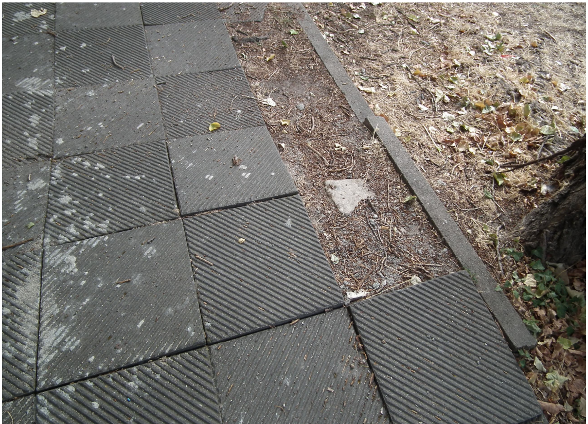
Foto 12 – Particolare della pavimentazione dissesata a causa delle radici degli alberi da potare.
