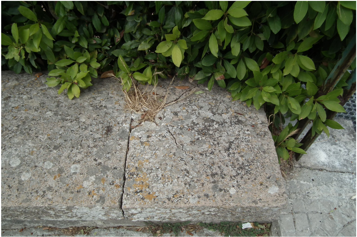
Foto 3 – Muratura perimetrale su via Dante: particolare delle lesioni sulla copertina
