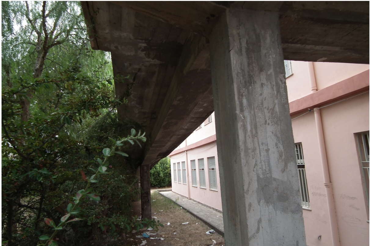
Foto 13 – Particolare dei pilastri in c.a. con esposizione dell'armatura
