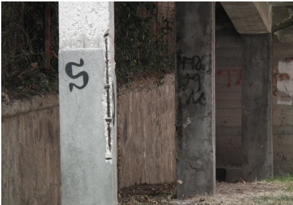
Foto 14 – Particolare dei pilastri in c.a. con esposizione dell'armatura.
