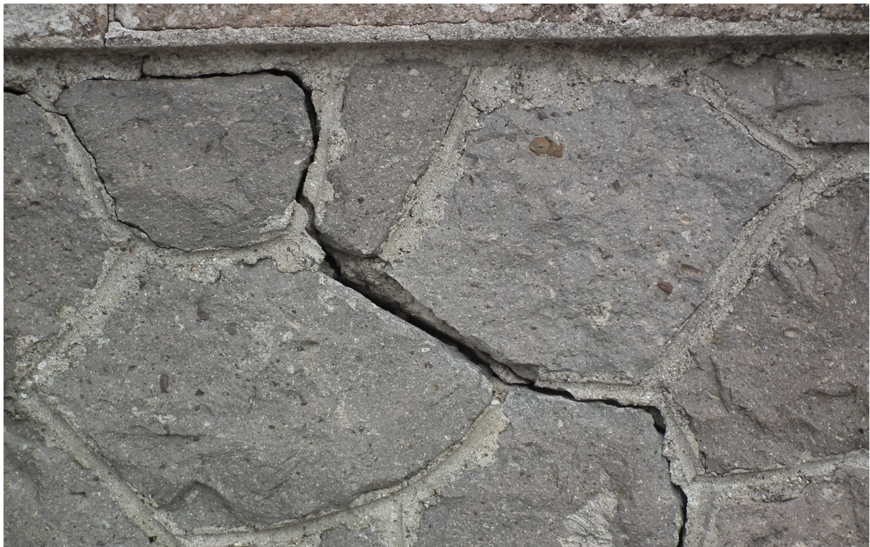
Foto 6 – Muratura di recinzione su via Brigata Sassari: particolare delle lesioni sulla muratura perimetrale
