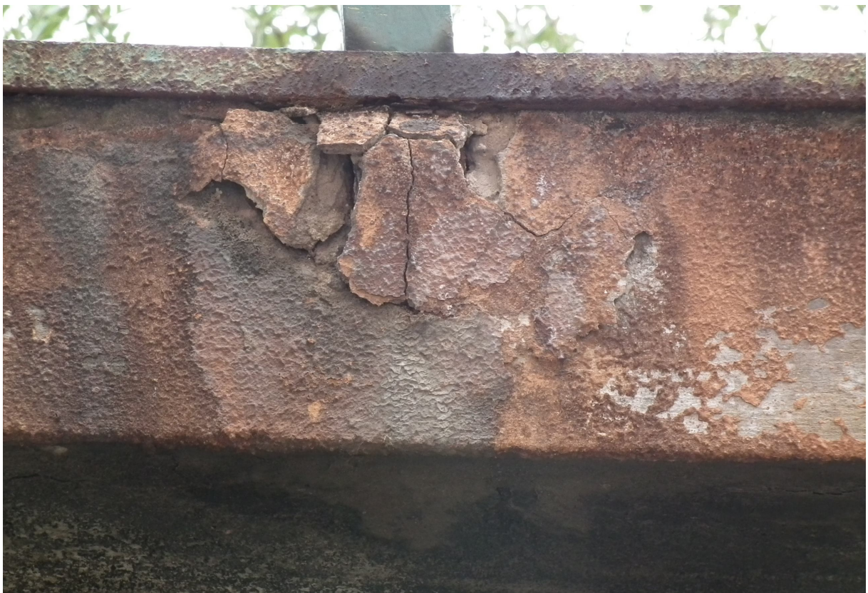
Foto16 – Passerella pedonale: soletta in c.a con particolare laterale dell'attacco della vecchia ringhiera.
