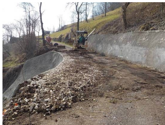
Esempio di intervento con calcestruzzo proiettato (spritz beton)
