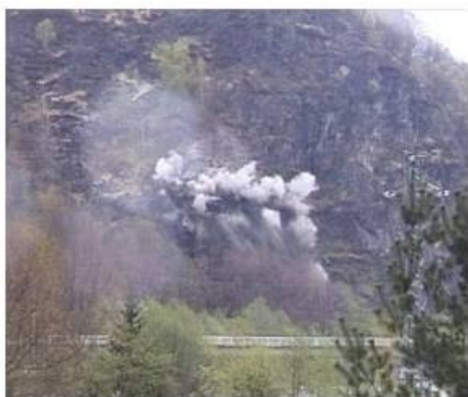
Esempio di abbattimento controllato con utilizzo di esplosivo (sinistra) e di disgaggio (destra)
