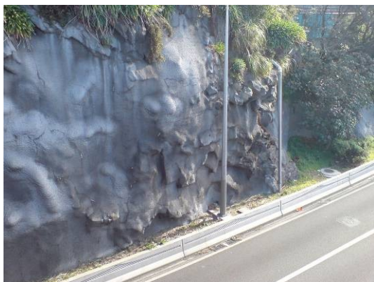
Esempio di intervento con calcestruzzo proiettato (spritz beton)
