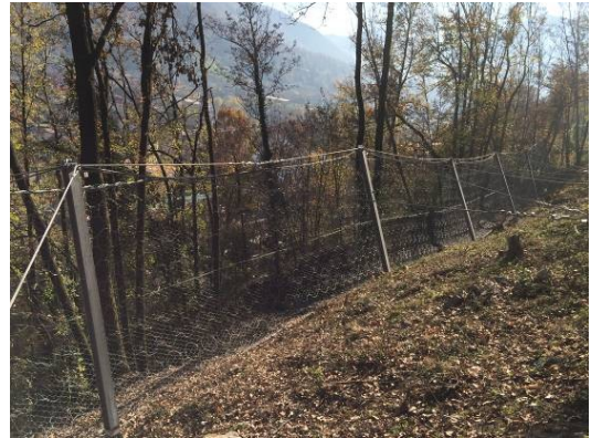
Esempio di installazione di barriere paramassi
