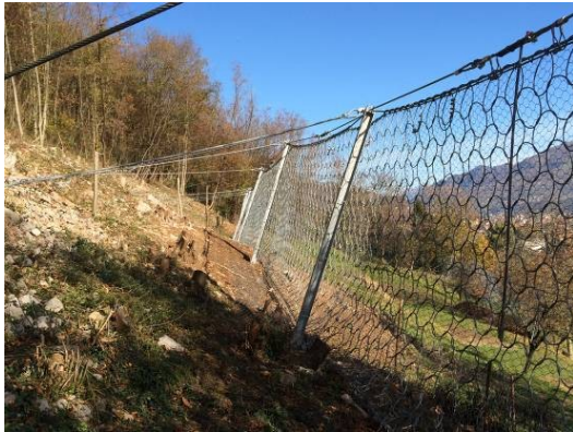
Esempio di installazione di barriere paramassi
