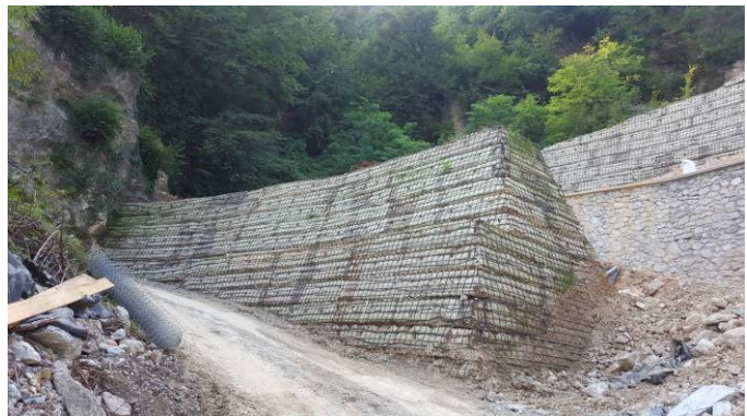
Esempio di realizzazione di rilevati
