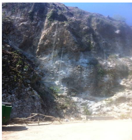
Esempio di intervento con rivestimento mediante reti in aderenza
