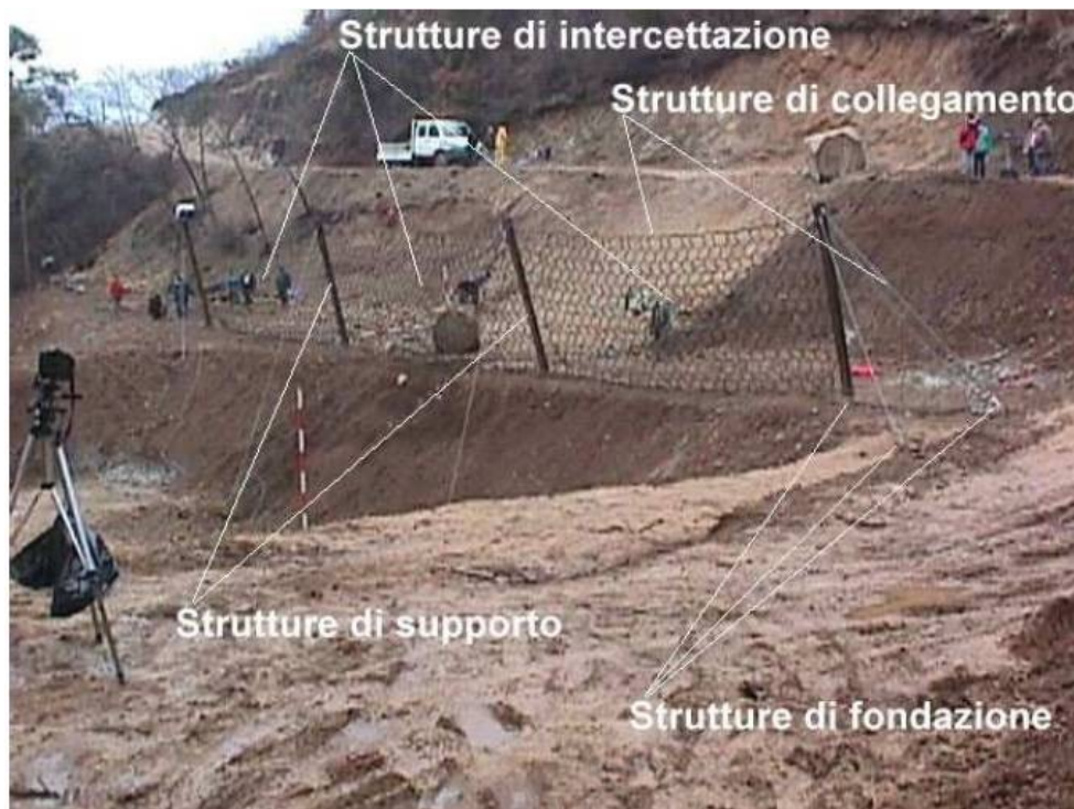
Elementi costituenti di una barriera paramassi
