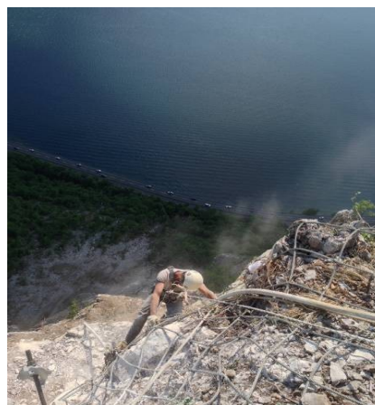
Esempio di intervento con rivestimento mediante reti in aderenza
